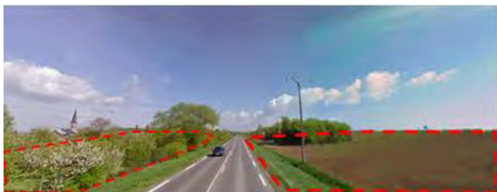
Vue depuis le Sud du site de projet. Les cultures à droite le site de projet d'implantation d'un front bâti cohérent le long de la voie. A l'arrière, une zone d'activité s'étendra jusqu'à l'autoroute. A gauche de la voie, les fonds de jardins aujourd'hui présents laisseront place à un front bâti cohérent, pour accueillir de l'habitat.
