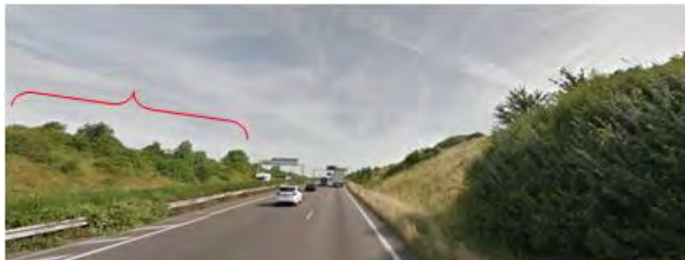
Vue depuis l'autoroute A31, au Sud-Est du site. Le projet se situe en contre-haut, à l'arrière du talus gauche.
