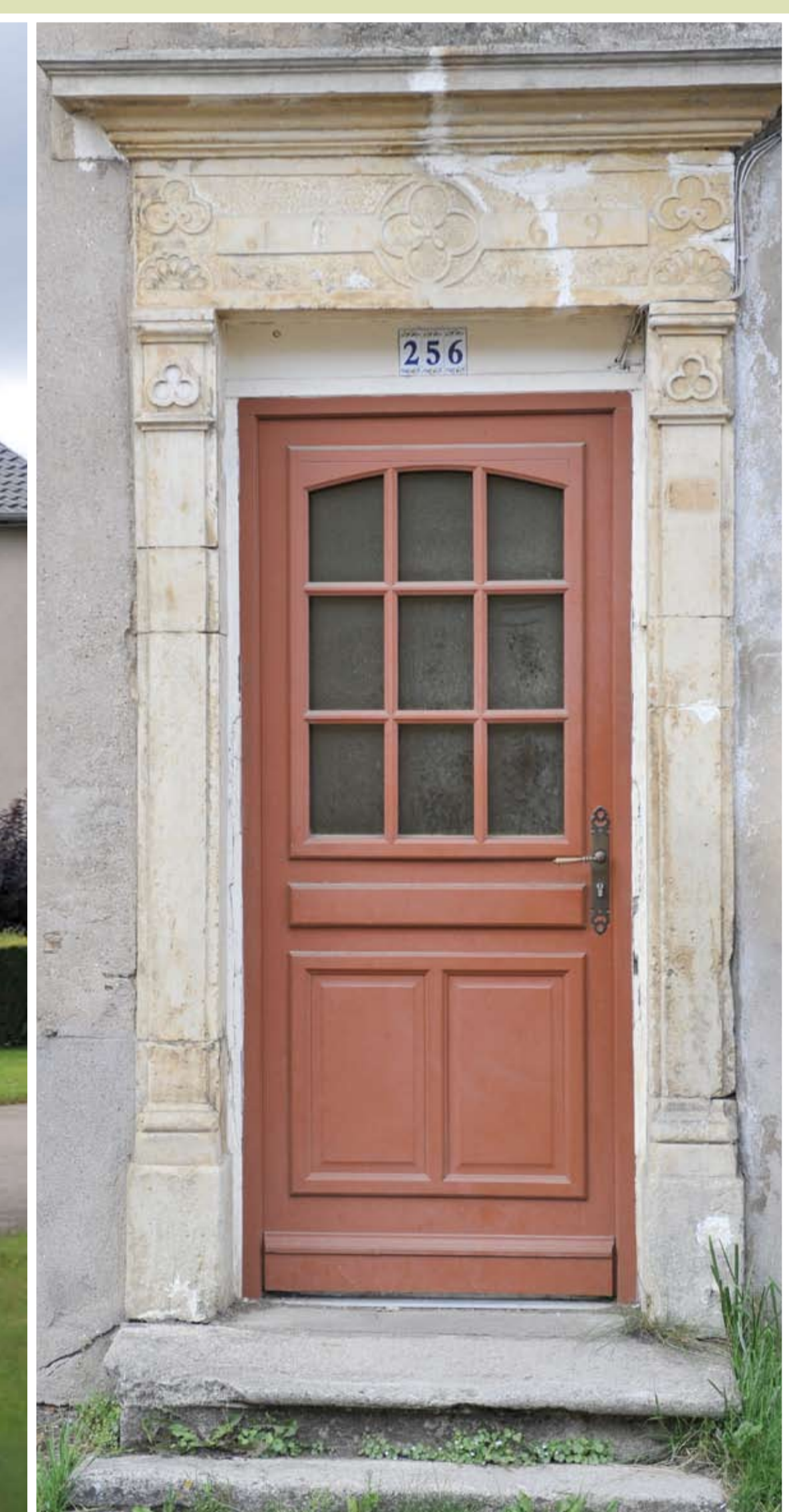
256 rue de Fontoy, porte piétonne à linteau daté et corniche moulurée
