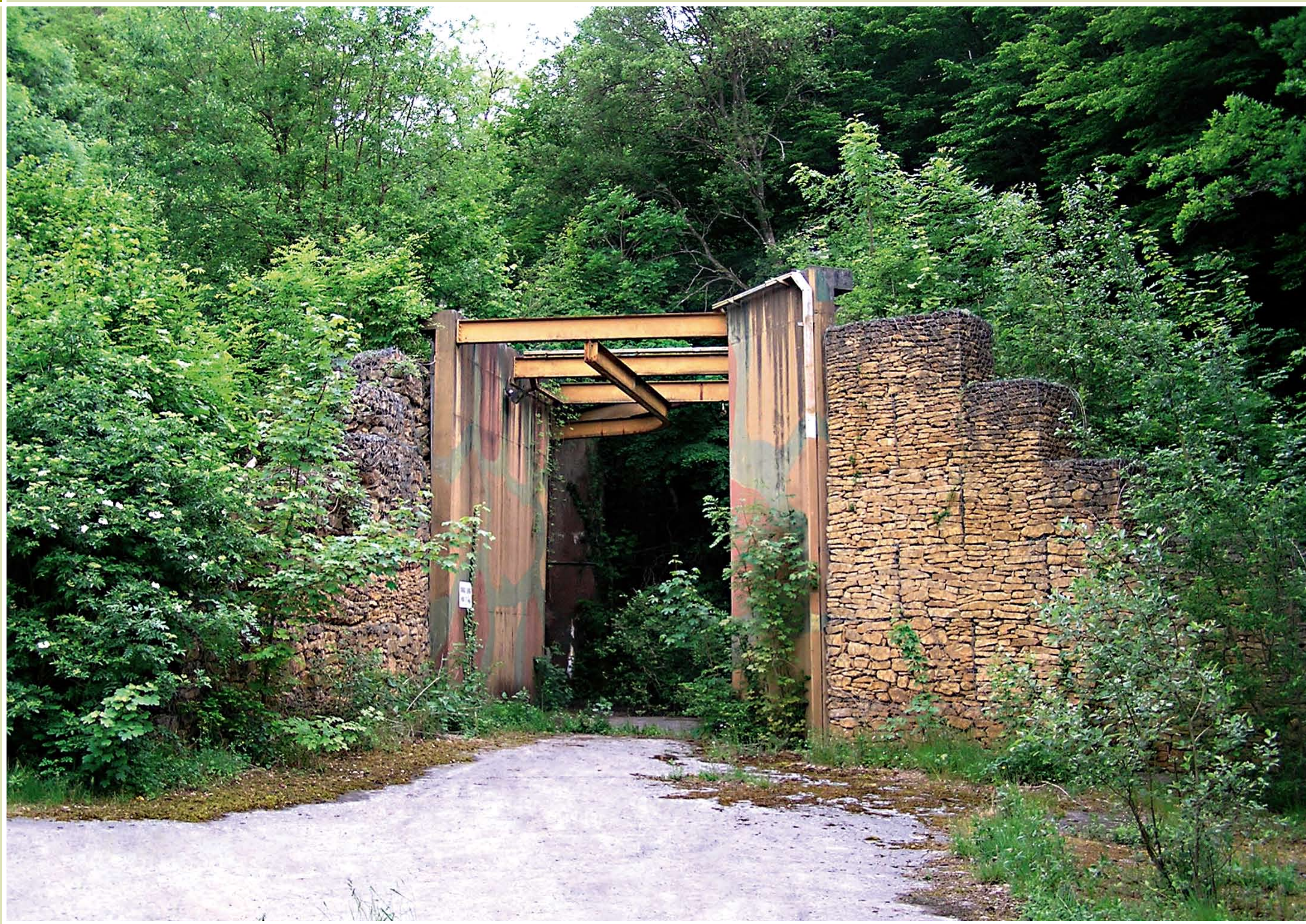
ANGEVILLERS, Gros-ouvrage de Rochonvillers, entrée des munitions avec mur anti-souffle
